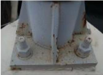
●Aグレードは例えば、道路に設置されている信号設備等のように十分な強度を持ったボルトとダブルナットで強固な固定が施工されている設備等。
