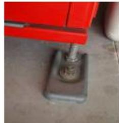
●Bグレードは例えば、一般設備である自動販売機がアンカーボルトと金具で床面と固定され設置されている設備等。
